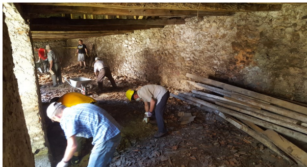
Aufräumarbeiten in den alten Wohnkammern
