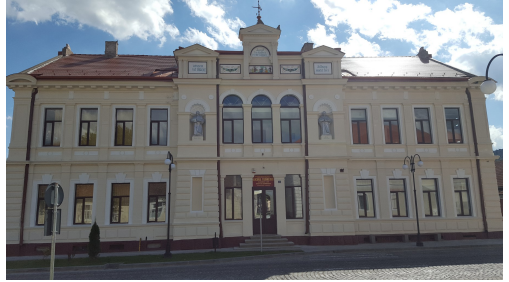
Die renovierte Fassade der Deutschen Schule
